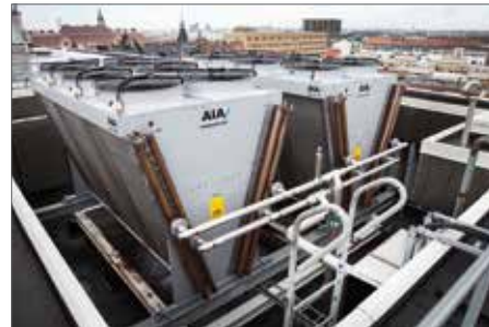
Kylmedelkylarna på taket har ett mycket begränsat utrymme med bostäder intill och höga knav på ljudnivån.
